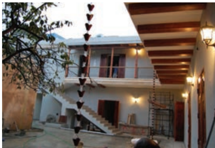
En el proceso de remodelación, interior.
