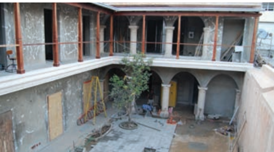
En el proceso de remodelación, interior.
