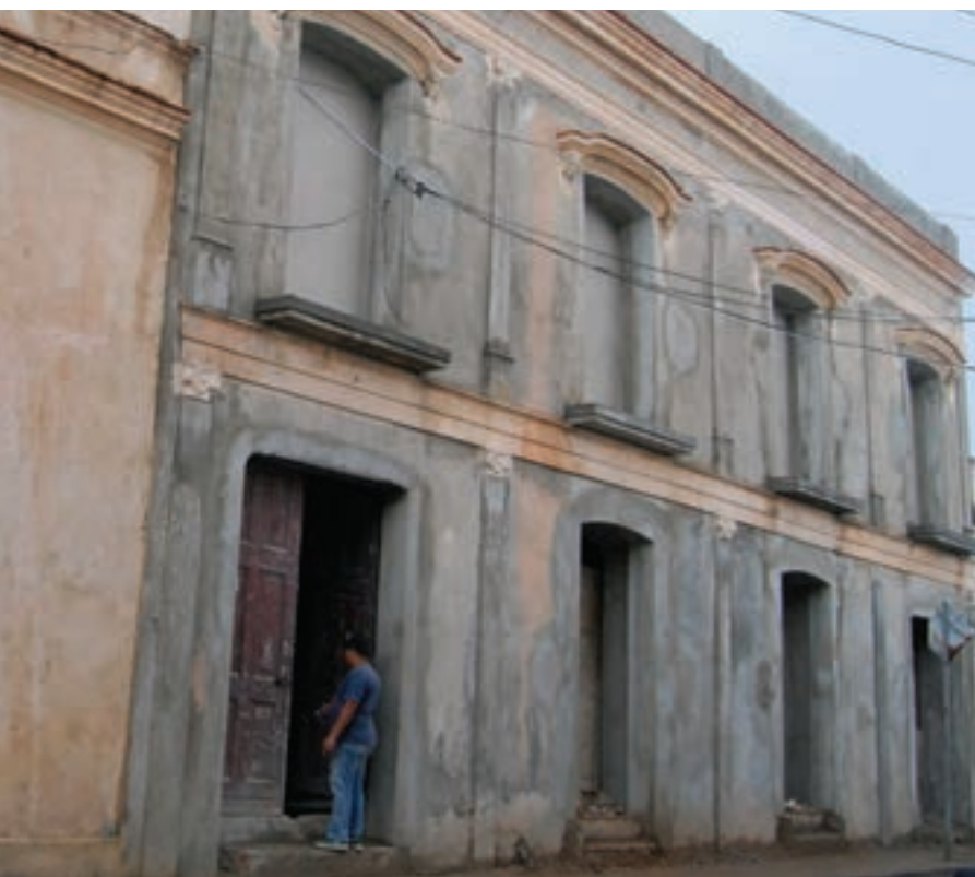
En el proceso de remodelación, exterior.
