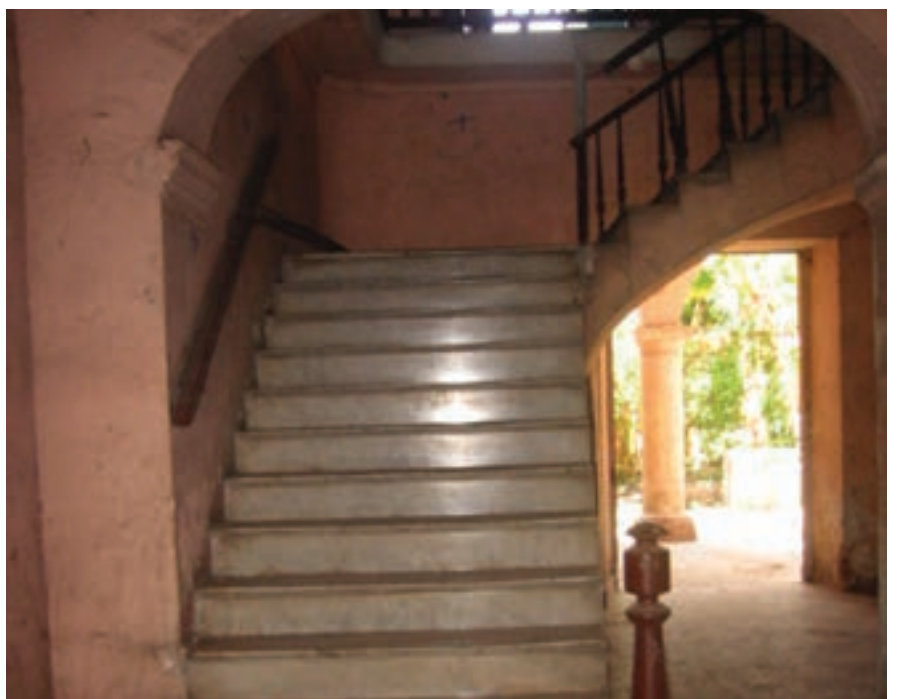
Interior del inmueble cedido por la Casa Vicini.
