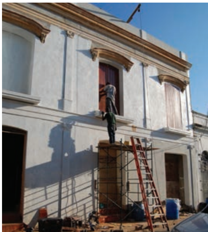
En el proceso de remodelación, exterior.
